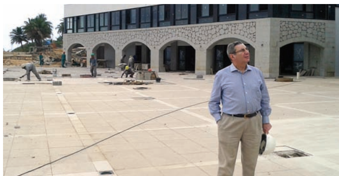
O conselheiro de Emprego e Seguridade Social, D. Pablo Figueroa Dorrego, visitando as obras do clube o passado setembro.
